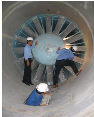
รูปที่ 6 ลักษณะการถ่วงสมดุลแบบภาคสนาม
